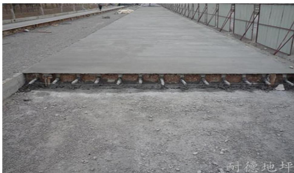
**Рисунок 4 – Устройство бетонной дороги**
