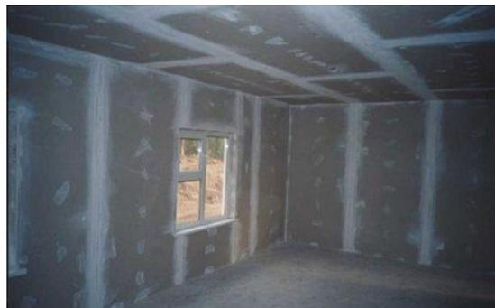
**Рисунок 2 – Общий вид комнаты со стенами из монолитного бетона в опалубке из ЦСП (а) и жилого дома (б)**
