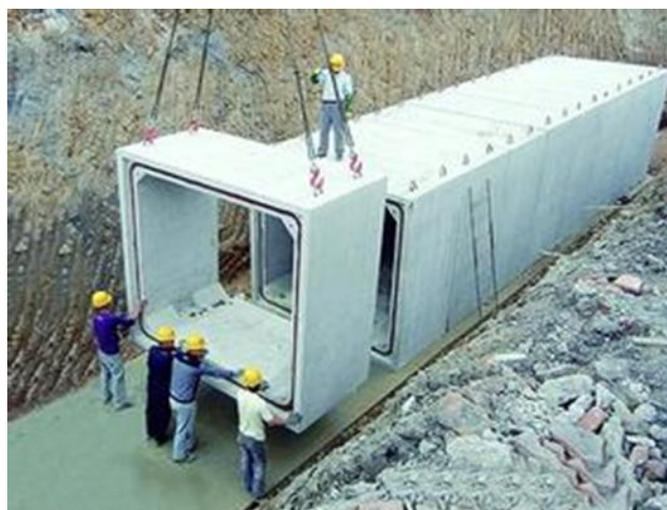
***Рисунки 2 – Использование напрягающего бетона при изготовлении труб***
