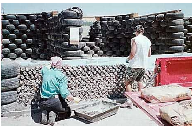
Рисунок 1 – Возведение стен и перегородок из шин
