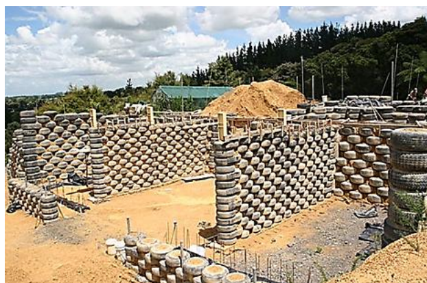
Рисунок 1 – Возведение стен и перегородок из шин
