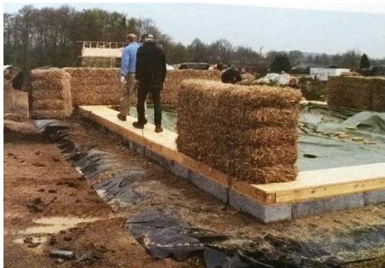
Рисунок 2 – Технология возведения бескаркасного дома из соломенных блоков
