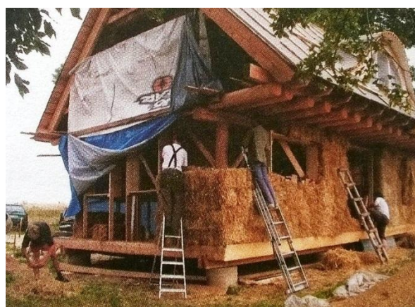
Рисунок 1 – Технология возведения каркасного дома из соломенных блоков
