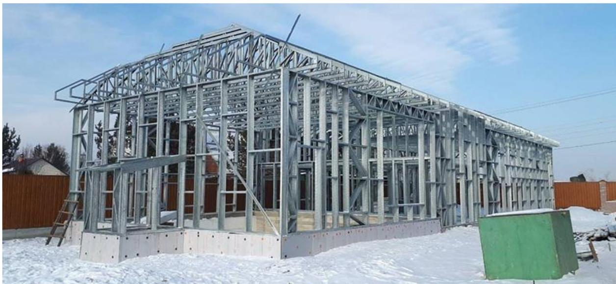
**Рисунок 1 – Несущий каркас жилого здания из ЛСТК**
